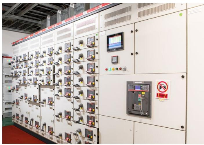
ABB厦门工业中心MNS Digital低压开关柜
