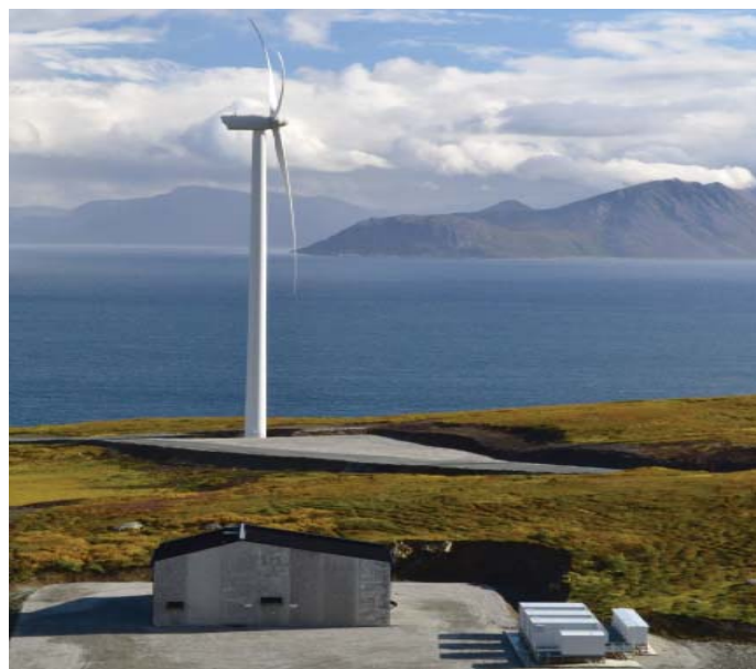
System STATCOM zainstalowany na obszarze farmy wiatrowej Fakken
