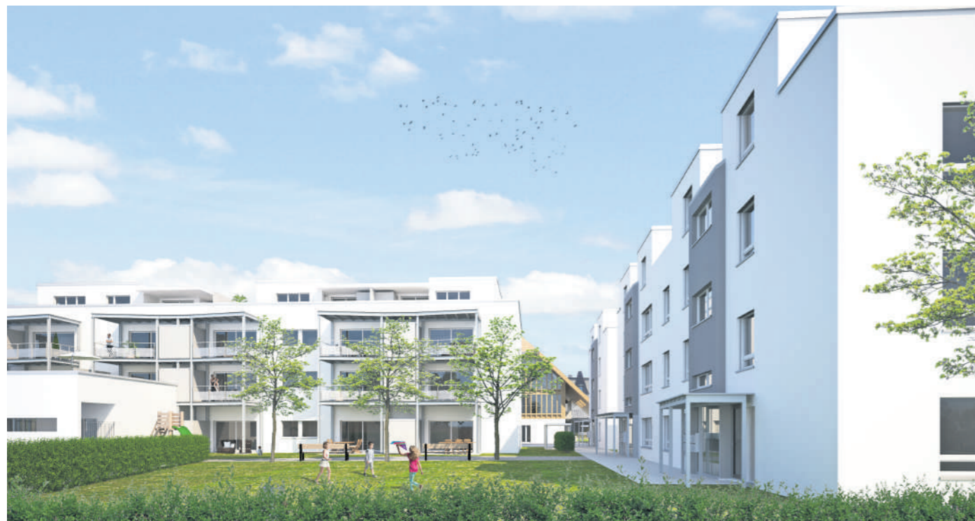
Bei den 53 Wohneinheiten im Projekt Dorfmatte in Utzenstorf und den Musterwohnungen von bonacasa sind die ABB-free@home-Haussteuerungen eingebaut.
