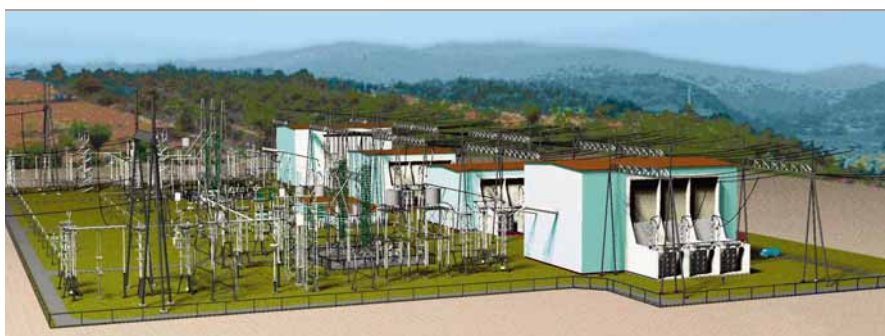
7 Station de conversion CCHT constituée de 4 blocs ; la configuration choisie minimise les effets des défaillances de chaque composant.
