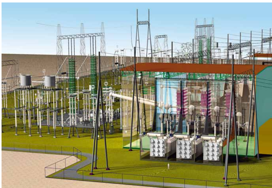
7 Station de conversion CCHT constituée de 4 blocs ; la configuration choisie minimise les effets des défaillances de chaque composant.
