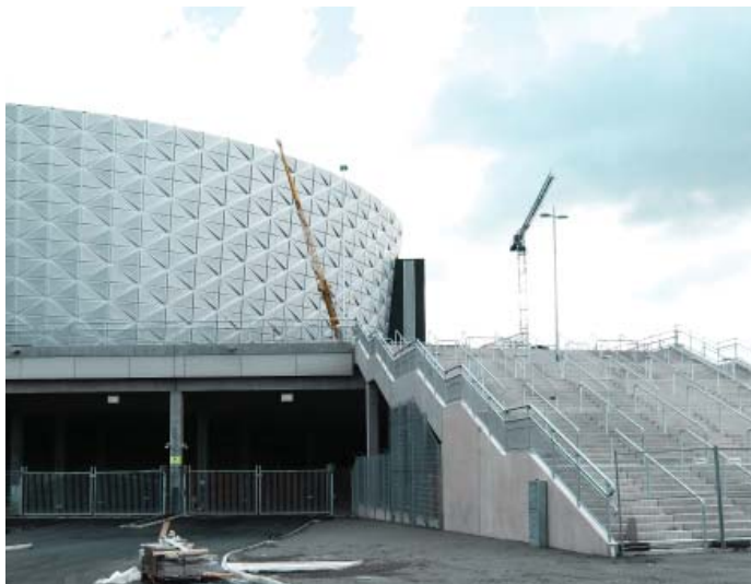
Kabelskåp för bygget av nya arenan "Friends" i Solna.
