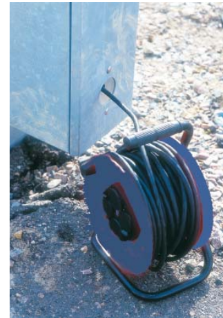
Öppningar på skåpets gavel används för bland annat tillfälliga uttag.
