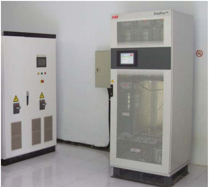
System EssPro PCS zainstalowany na wyspie Kai Besar
