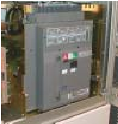
Air Circuit Breaker Emax - E3
