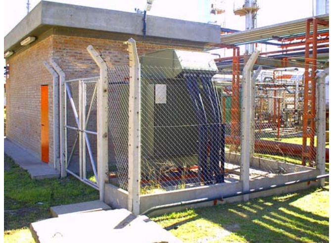
Fig. 7 (d) Isolation transformer next to converter building
