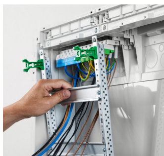
13 Szybkie i łatwe zatrzaskiwanie wstępnie zmontowanych profili montażowych za pomocą systemu szybkiego montażu (QMS)
