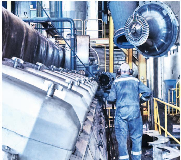
Um dos upgrades com maiores exigências logísticas foi executado recentemente pelo fabricante de motores Wärtsilä e pela equipa de turbocompressores da ABB em Portugal e envolveu o upgrade de oito turbocompressores TPL 77 dos motores da Central Termoeléctrica do Caldeirão. A Central está localizada em São Miguel, uma das ilhas da Região Autónoma dos Açores, território Português que fica no Atlântico, a cerca de 1.800 km a oeste de Portugal continental.
