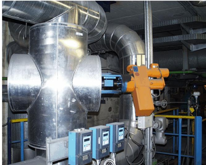
Рисунок 35: Линейный привод в горизонтальном монтажном положении (регулирование воздуха)
