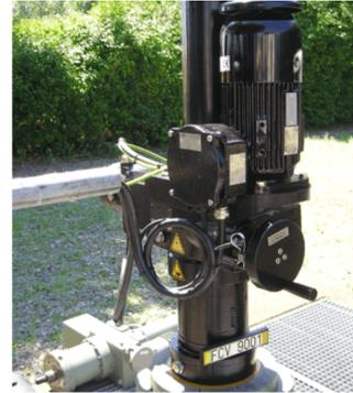
Рисунок 30: Contrac RSDE20 на газораспределительном узле
