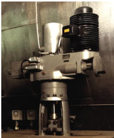
Рисунок 34: Линейный привод (подогрев питательной воды)
