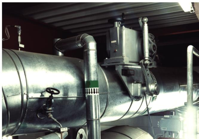
Рисунок 36: Поворотный привод (регулирование воздуха)
