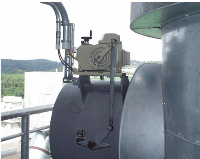
Рисунок 37: Регулирование воздуха в мельнице; поворотный привод RHD250 (номинальный крутящий момент 250 Нм)
