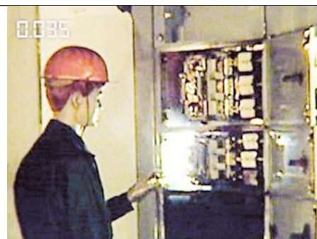
1b 采用 ABB 弧光监测系统时发生的电弧事故
