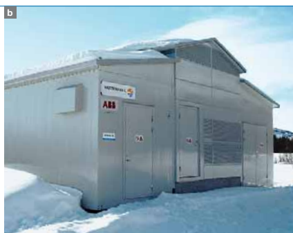
5 Poste préfabriqué de type MALTE: a ancien ouvrage, b nouveau génie civil et c intérieur du poste: transformateur (milieu), cellule HT (droite), cellule MT et équipements secondaires (gauche)
