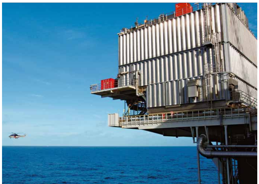
2 Module HVDC Light® de la plate-forme Troll A de Statoil
