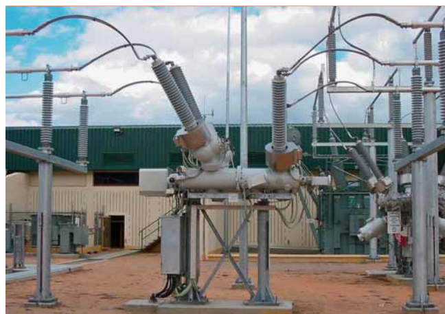
1 L'appareillage compact hybride PASS M0 170 kV d'ABB multiplie les fonctions.
