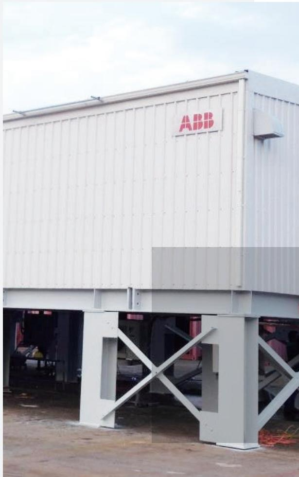
为实现将世界级工业带到南澳大利亚地区的雄心，客户建设了一套新的空分装置，为多金属回收和再循环设施的新工业流程提供氧气和氮气。空分装置多采用模块化设计与建设，来提高效率并缩短交付周期，客户要求为空分装置提供模块化的电气解决方案，将整厂的中低压开关及控制设备集成在预装式变电站内，并在工厂实现电气设备的预装和预调试工作。
