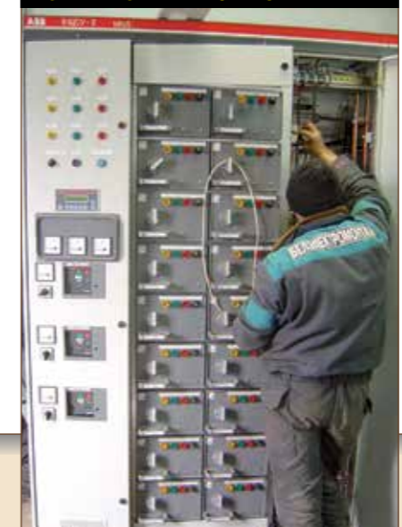
MONTAŻ ROZDZIELNIC MNS W RAFINERII
