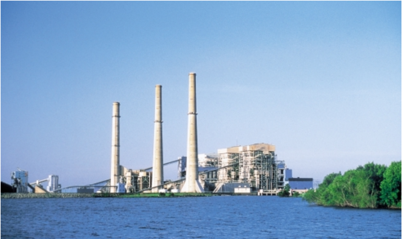
Vue de la centrale de Fayette (Lower Colorado River Authority, La Grange, Texas). Cette centrale thermique au charbon compte 3 chaudières de 600/600/450 MW, toutes équipées d'électrofiltres ABB.
