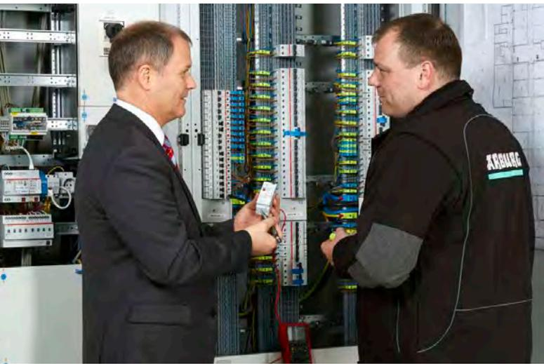
Geräte und Komponenten können mit SMISLINE TP ohne zusätzliche Schutzausrüstung unter Spannung aufgesteckt und entnommen werden. Für Planer, Schaltanlagenbauer und Bauherren gibt es verschiedene gute Gründe für die Wahl des Stecksockelsystems SMISLINE TP:
