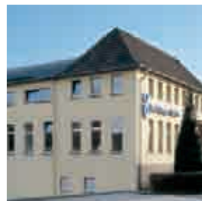
Zakład w Aue o powierzchni produkcyjnej ponad 14.000 m 2
