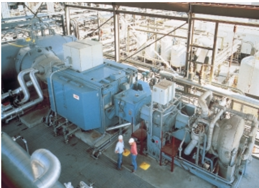
VAX-ångturbinaggregat med högtrycksturbin och växel på den ena sidan av generatorm och lågtrycksturbinen med kondensator på den andra sidan
