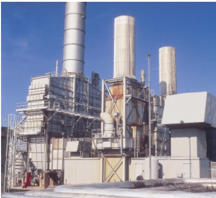
Kraftverk med kraftvärmekoppling i ett raffinaderi i grekiska Korint, utrustat med 2 gasturbinaggregat av typ GT35
