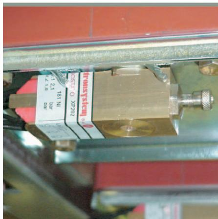
**Primo livello - intervento per pressione bassa:** si ha l'indicazione quando la pressione del gas scende da 380 kPa assoluti ad un valore inferiore a 310 kPa assoluti.
