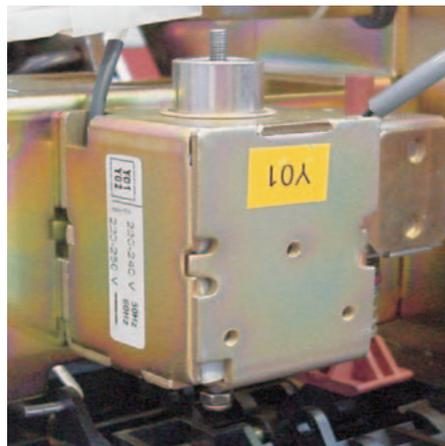
Specificare la tensione di alimentazione. La tensione di alimentazione dello sganciatore di apertura deve coincidere con quella dello sganciatore di chiusura (e delle lampade se previste) quando è richiesto il dispositivo di blocco dell'interruttore per pressione insufficiente.
