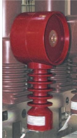
I sensori di corrente provvedono ad inviare al relè il segnale di corrente da elaborare e forniscono l'energia per alimentare il relè e il solenoide di apertura in caso di intervento. Il kit comprende tutti gli accessori per il montaggio dei sensori eccetto il cablaggio di collegamento al relè.
