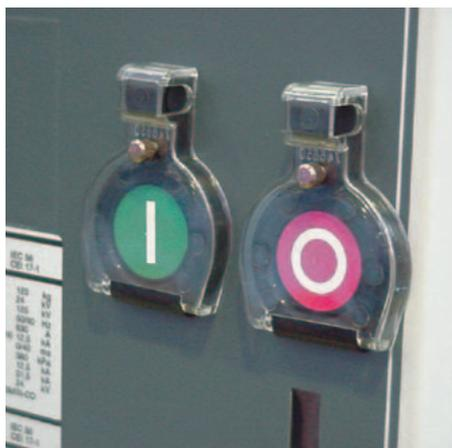
Permettono di bloccare i manipolatori del comando dell'interruttore.
