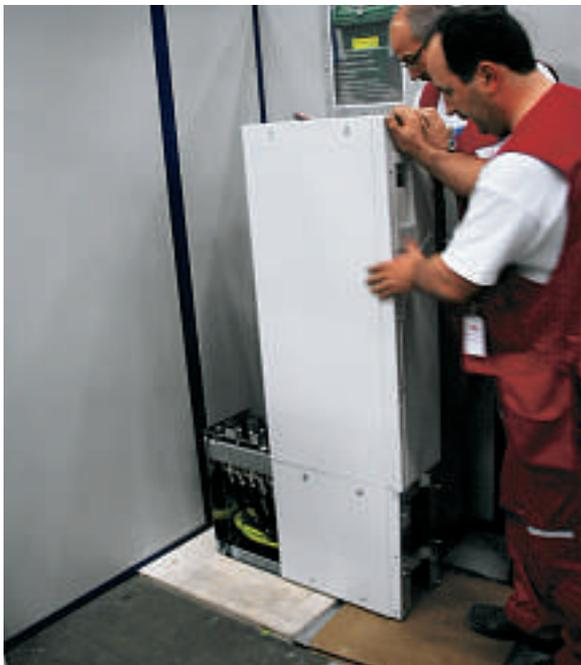
L'ACS 800 résout ce problème avec un mode de câblage résolument nouveau pour les convertisseurs de fréquence. Les câbles réseau et moteur des variateurs de forte puissance au format livre sont raccordés sur un piédestal fixé au sol **2**. Une fois le câblage terminé, le module variateur auto-porteur sur roulettes est glissé sur le piédestal et bloqué en position **3**.
