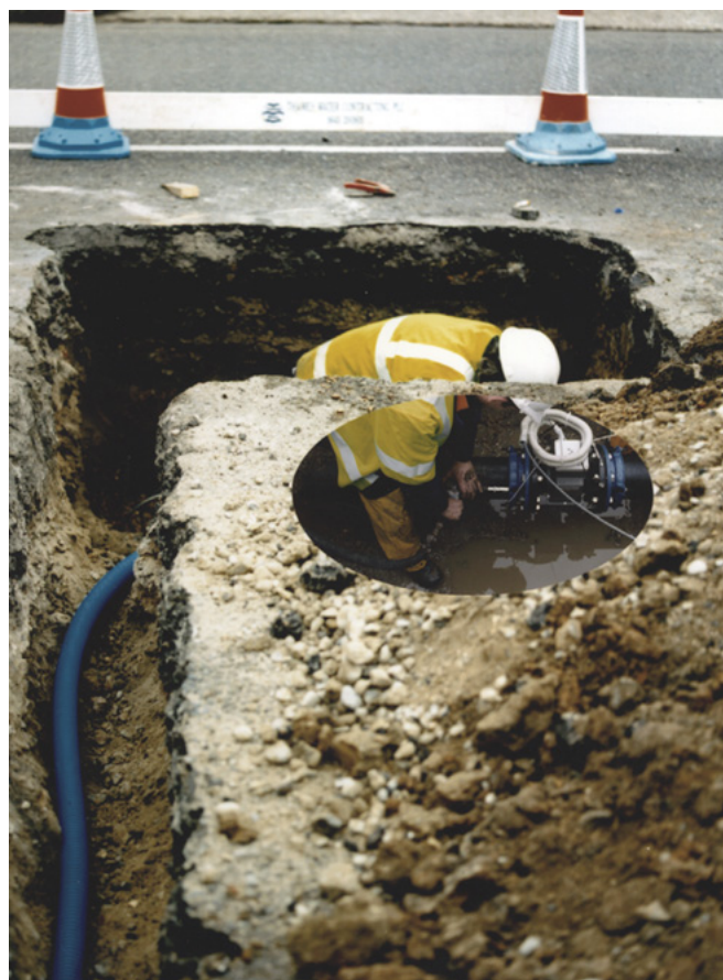
Installation enterrée de MagMaster
