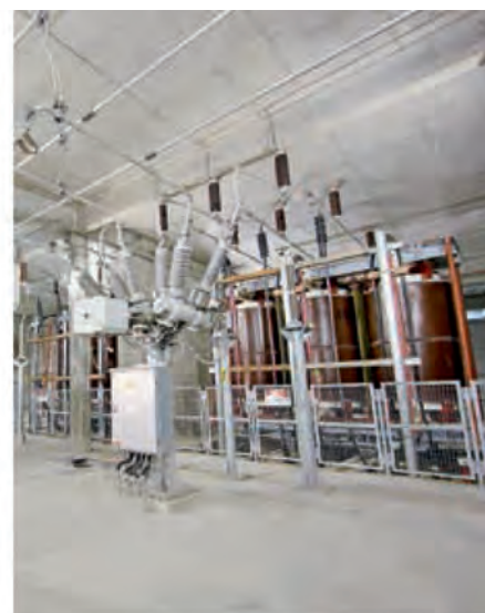
5b: ไสบริดสวิตช์เกียร์ SF6/อากาศ PASS M00 72.5 kV
