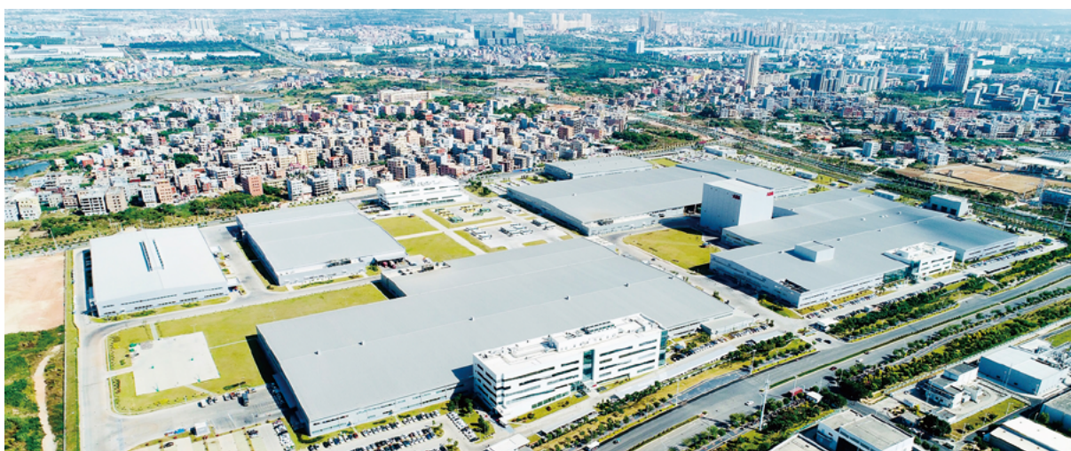
图 6-9 ABB 厦门工业中心
