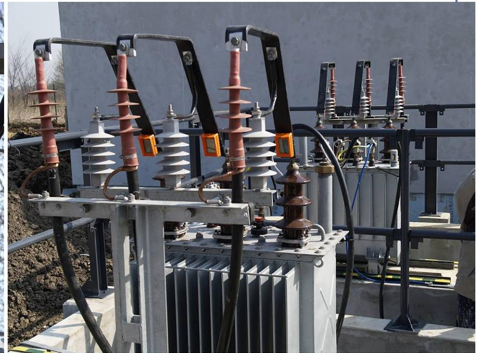
Transformador auxiliar 15/0.4kV
