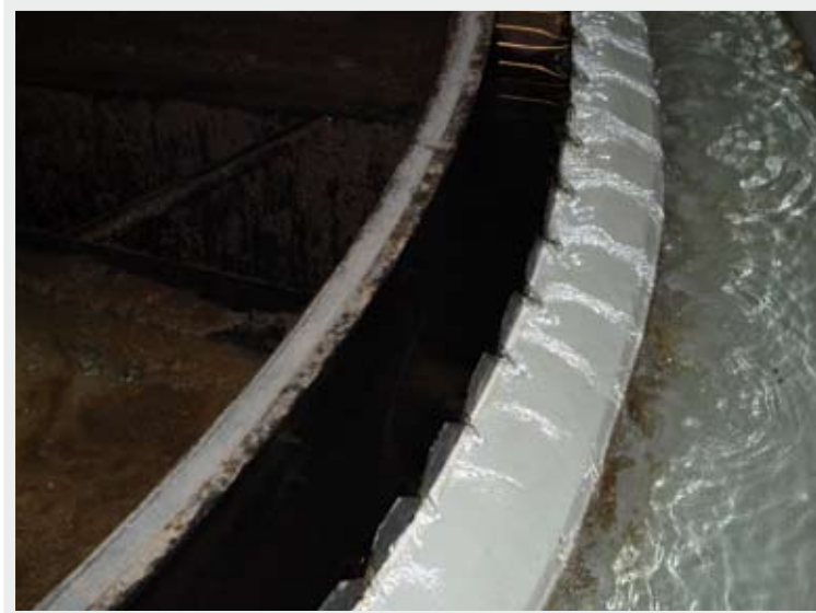
Fig. 3 - Acqua in uscita dall'unità di flottazione
