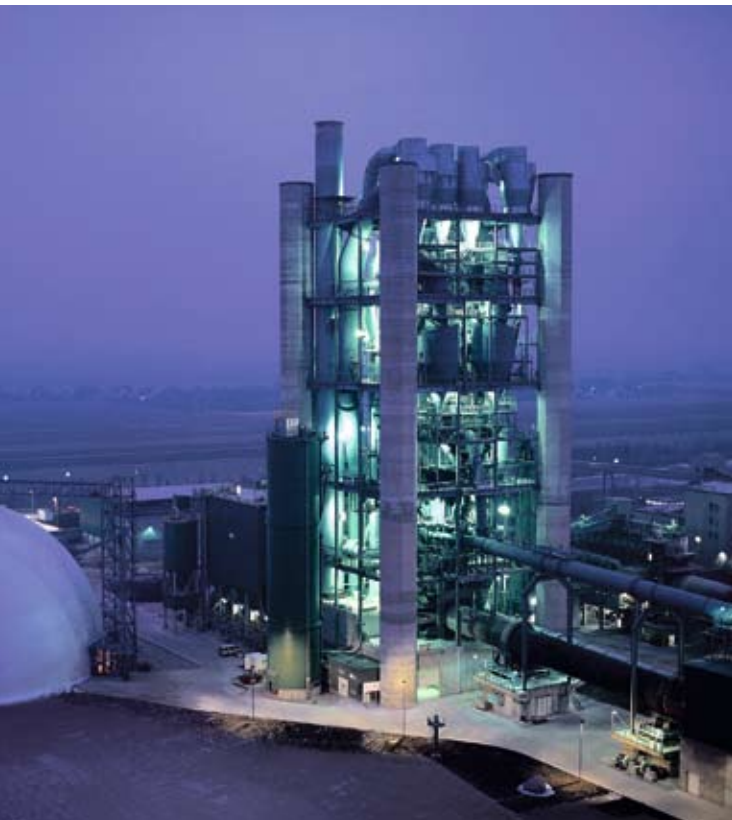
9 Holcim-Werk Lägerdorf, Ofenlinie 11 9 Holcim plant Lägerdorf, kiln line 11
