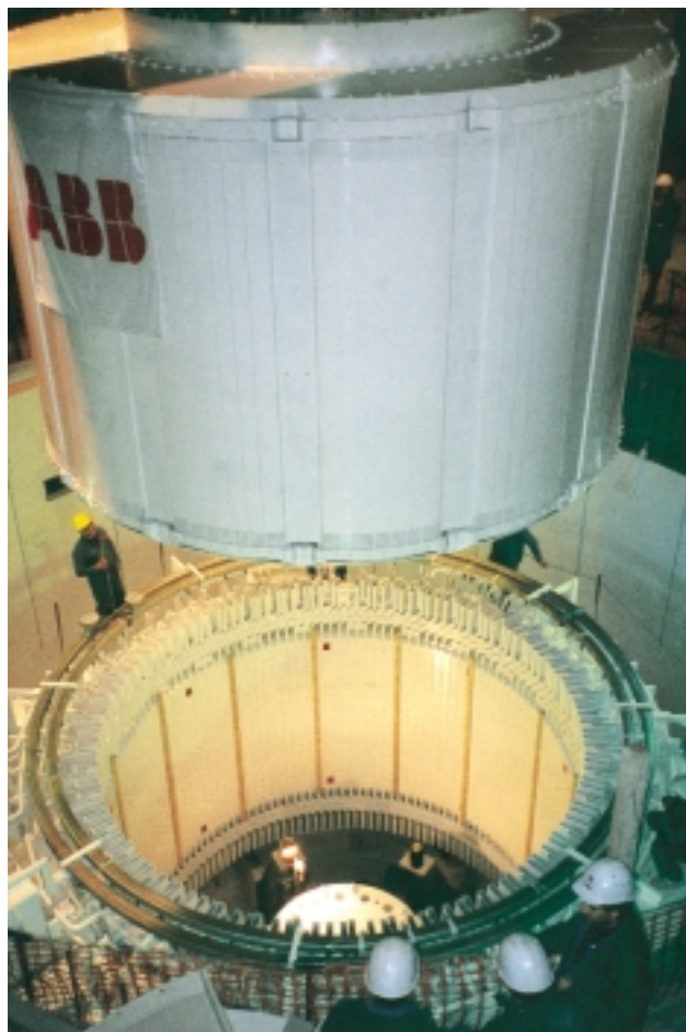
1 Montering av en generator på 465 MVA i berggrummet till vattenkraftverket Bieudron. 2 Här visas det kritiska momentet när den 454 ton tunga rotorn sänks ner i statorn.
