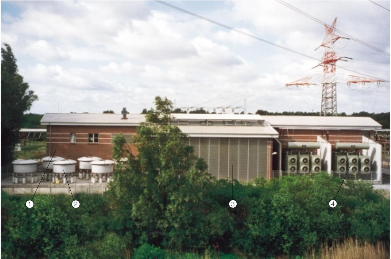
**Vollstatische 100-MW-Frequenzkupplung Bremen**
