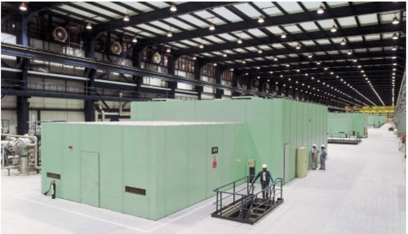
Vue de la salle des machines longue d'environ 300 m de la centrale Al Taweelah B, avec les 6 turbogroupes entièrement carénés
