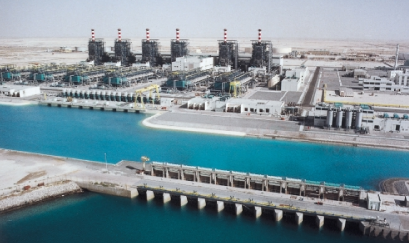
La centrale à vapeur d'Al Taweelah B à Abu Dhabi. Derrière la ligne de pompes du bassin d'entrée de l'eau de mer, les 6 lignes de dessalement avec entre deux les bâtiments de commande. La mosquée est visible tout à droite, à la hauteur des 6 générateurs de vapeur.
