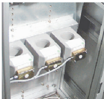
Fig. 7.8.4.1: Ring core sensors
