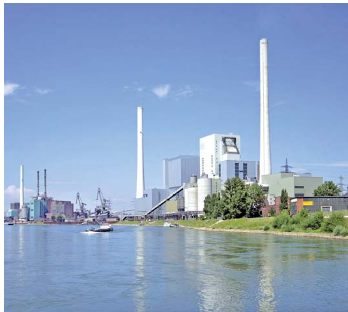
La centrale GKM è un impianto a carbone ad alta efficienza tecnologicamente avanzato.
