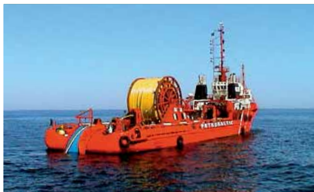
3 Die Gaspipeline wurde in 11 km langen Segmenten vom Schiff aus abgerollt.
