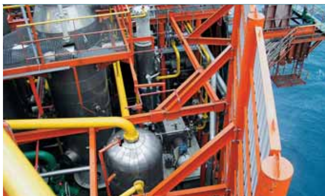
2 Erste Aufbereitung des Erdgases auf der Bohrplattform «Baltic-Beta». Dieses Gas wurde früher einfach abgepackelt.
