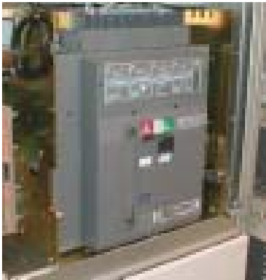
Air Circuit Breaker Emax - E3
