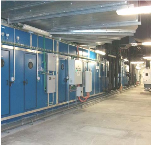
UTA con regulación de velocidad ABB
