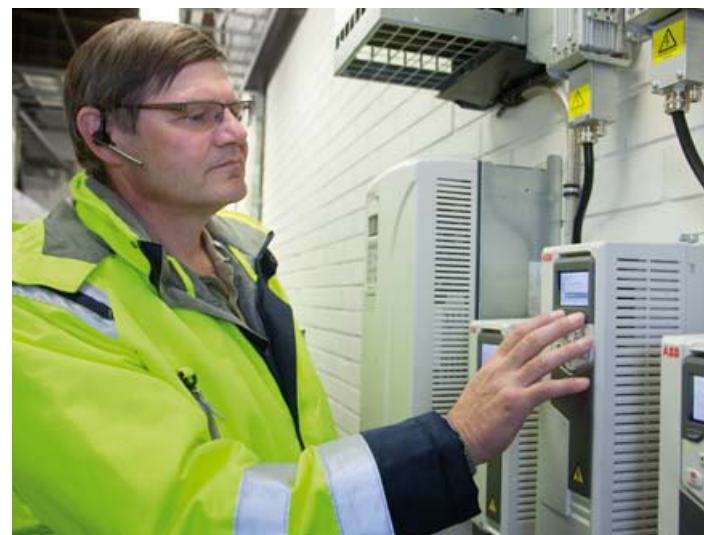
ACS580-01 väggmonterade standardfrekvensomriktare är enkla att använda och konfigurera för olika tillämpningar som transportörer, pumpar och fläktar.
