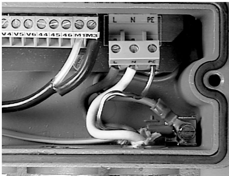
**FIGURE 2-7. POWER CABLE WIRING**
