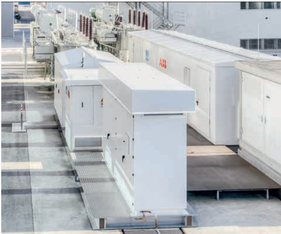
5 Système EssPro Grid de 1 MW/15 min installé chez l'énergéticien suisse EKZ, à Dietikon.
