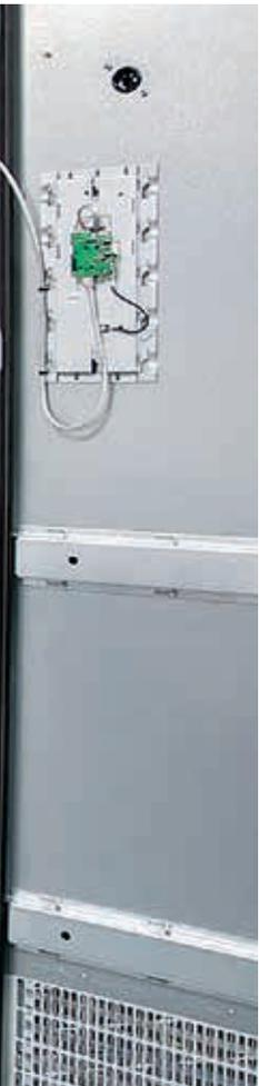
ken entfernt und maßgeschneiderte ACS880-Retrofit-Kits für die etwas breiteren ACS600MD-Schänke installiert →5. Die Steuerung der Umrichter erfolgt weiterhin über das vorhandene AC80-Steuerungssystem mit einigen Modifikationen der AC80-Software. Der Projektumfang beinhaltet die Inbetriebnahme, und die geringfügigen Programmänderungen für die neuen ACS880 werden während der Wartungsstillstände durchgeführt.“
