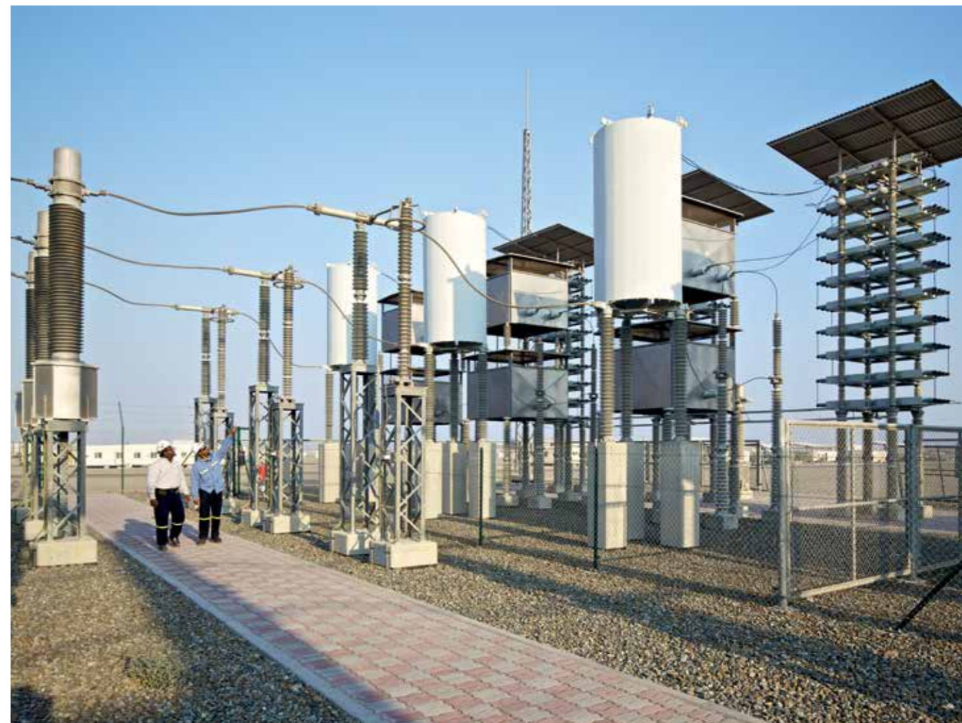
Przełącznik został przetestowany i certyfikowany do 50 tys. cykli (załóż/wyłóż). To sprawia, że DS1 jest obecnie najtrwałszym przełącznikiem obsługującym baterie kondensatorów na rynku.
