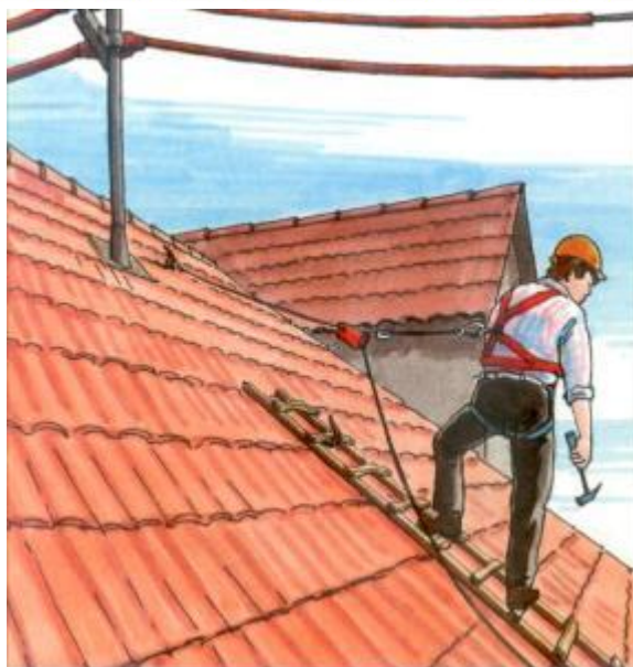
Munkavégzés tetősíkon rögzített tetőlétráról
