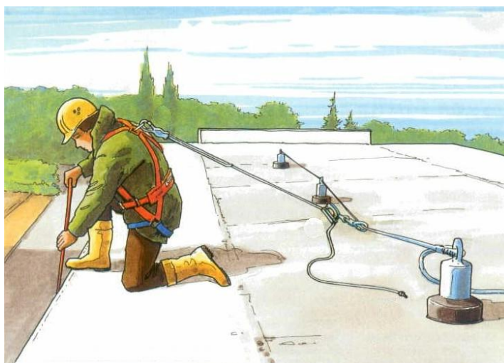
Munkavégzés a födém szélének veszélyes közelében
