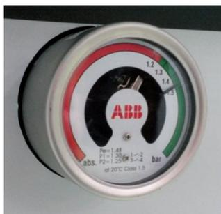
O manómetro apresenta a pressão do gás e fornece uma indicação analógica do seu valor. As informações podem ser vistas na frente do painel e também podem ser transmitidas por controlo remoto mediante cablagem dedicada e bloco de terminais. Consulte o esquema do circuito.
