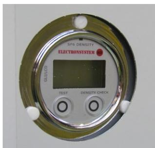
O medidor de densidade monitoriza a pressão do gás e emite um alarme que assinala quando a pressão está baixa.
