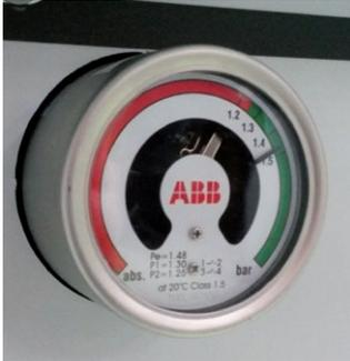
Apresenta a pressão do gás e fornece uma indicação analógica do valor. As informações podem ser vistas na frente do painel e também podem ser transmitidas para outra localização, mediante cablagem dedicada e bloco de terminais. Consulte o esquema do circuito.
