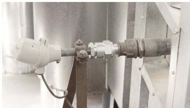
Рисунок 4: Высокотемпературный датчик в печи
