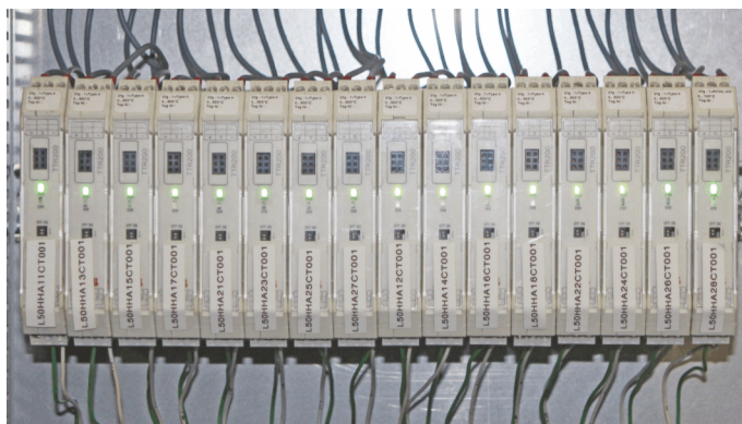
Рисунок 12: Измерительный преобразователь для монтажа на шине
