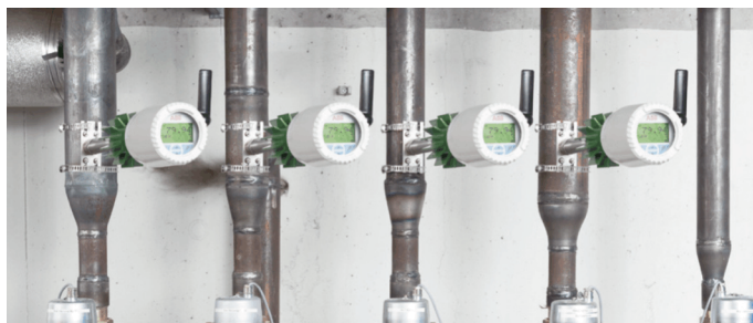
Рисунок 14: Датчик температуры со встроенным источником энергии Energy Harvester для монтажа на поверхность
