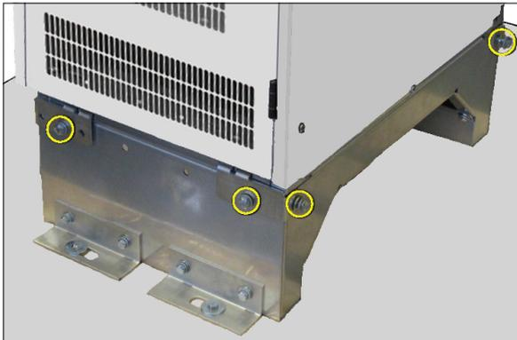
3. Fije los soportes de la placa de cubierta delantera al zócalo con tornillos (M8×20 hexagonal de rosca completa o igual) y arandelas y tuercas M8.
