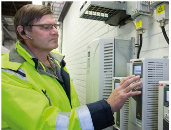
Los convertidores de frecuencia de propósito general ACS580-01 para montaje en pared son fáciles de usar y configurar para aplicaciones diversas, como cintas transportadoras, bombas y ventiladores.
