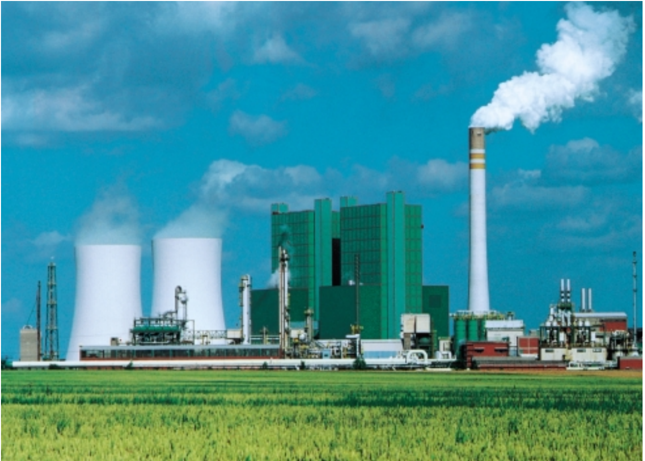
900-MW-Braunkohlekraftwerk Schkopau, Ostdeutschland. Die beiden Blöcke arbeiten unabhängig voneinander und erzeugen elektrische Energie für die öffentliche Stromversorgung sowie für die Deutsche Bahn AG. Zudem liefern sie thermische Energie für die chemische Industrie.
