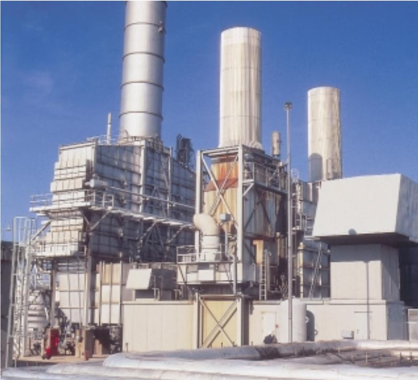
**Centrale avec production combinée de chaleur et d'électricité dans une raffinerie de Corinthe, Grèce, équipée de deux turbogroupes à gaz GT35**
