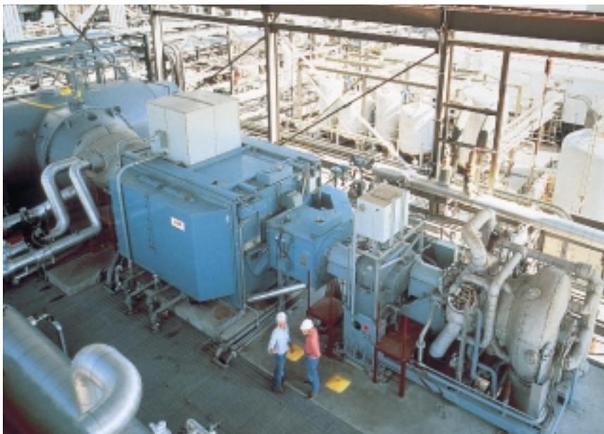
**Turbogroupe à vapeur VAX avec une turbine haute pression et un engrenage sur un côté de l'alternateur et une turbine basse pression avec condenseur sur l'autre côté** 11
