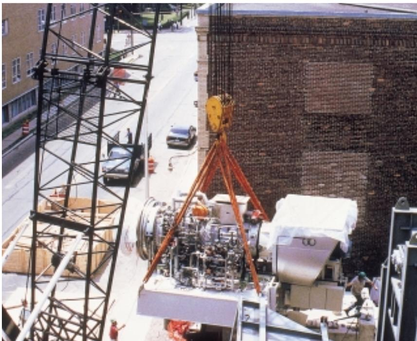
**Une turbine à gaz GT10 est hissée dans un bâtiment existant sur le terrain du Massachusetts Institute of Technology (M.I.T.), à Boston, USA** **7**
