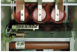
Resistenza anticondensa. Anticondensation heater.
