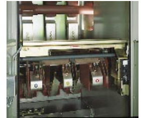
Sezionatore di terra. Earthing switch.
