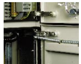
Messa a terra delle porte. Door earthing.
