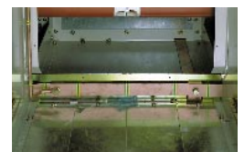
Sbarra di terra. Earthing busbar.
