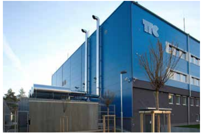
TTC TELEPORT data center
